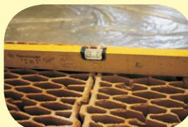
První vrstva se zakládá pomocí nivelačního přístroje, pro zajištění dokonale rovinosti zdiva.
