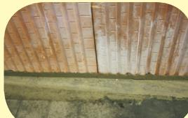
Tloušťka ložné spáry může kolísat mezi 10 mm a 40 mm.
