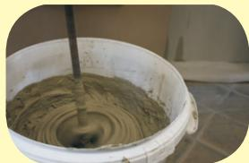
Pokud nám malta postupně houstne, opětovným promícháním el. míchadlem, bez přidání vody získá zpět svou původní elasticitu. Pokud by bylo nutné zvýšení podílu vody v již namíchané maltě (např. v horkém počasí), vodu přileváme pomalu a opatrně, tak aby na konci míchacího cyklu byla malta požadované konzistence.
