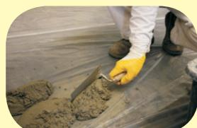
Nanášení malty se provádí zednickou lžíce nebo fankou.
