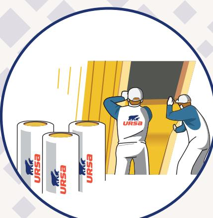
Aplikace minerální izolace URSA DF 38 mezi krovky. Izolaci mezi krovky postupně vkládáme lehkým vtláčením po obou stranách její výšky, až zaplníme celé krovkové pole. K zajištění izolace v krovkovém poli při aplikaci použijte fixační prvky např. drátkování.
